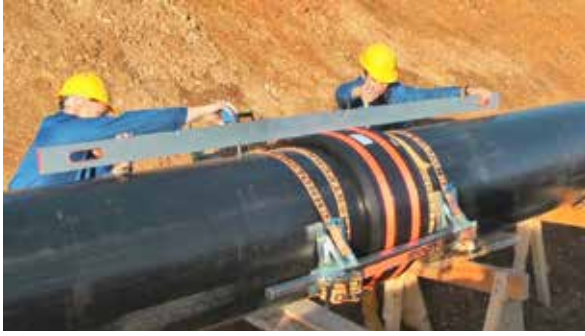
Abbildung C.21: Montage der Halteklemmen und Ausrichten des Rohrs
