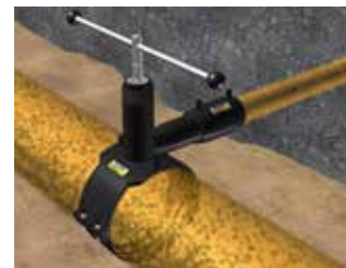
Abbildung C.35: Anbohren der Leitung
