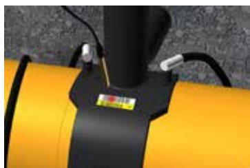
Abbildung C.34: Eingabe der Schweißparameter
