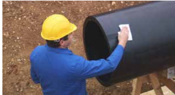
Abbildung C.20: Reinigung des Rohrs
