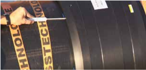
Abbildung C.25: Kontrolle des Ringspaltes mit der Spaltlehre
