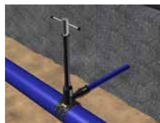
Abbildung C.39: Anbohren der Leitung
